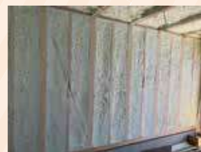
吹付断熱工法
